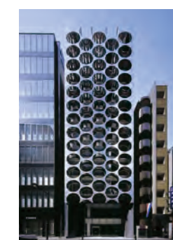
ビル外装パネル
