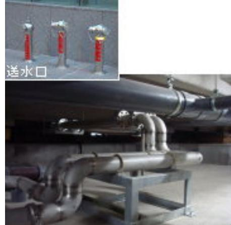
2006年10月に消防法施行規則が改正され、従来、使用出来なかつた連結送水管を中心とした消防設備配管に、ステンレス管の使用が可能となつた。
