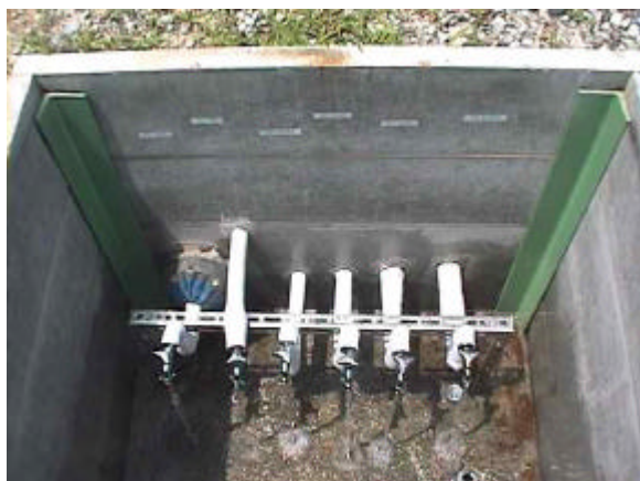
写真3．取水栓 (左から 75DIP、20PP、20HIVP、20SSP、
