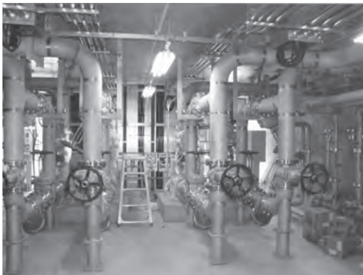
▲浄水場装置配管
