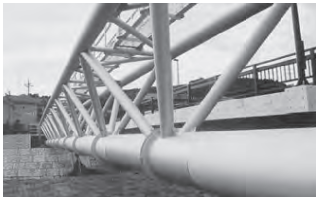
▲トラス補剛形式水管橋
