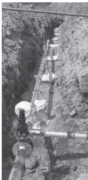
▲自動溶接工法
