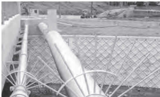
▲橋梁添架形式パイプビーム水管橋
