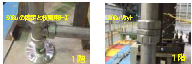
写真-5 加震後のステンレス配管取り付け状況 (その1)
