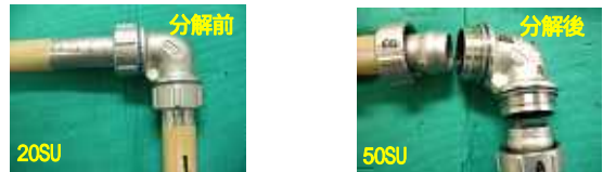
写真 9 回収したメカニカル継手
