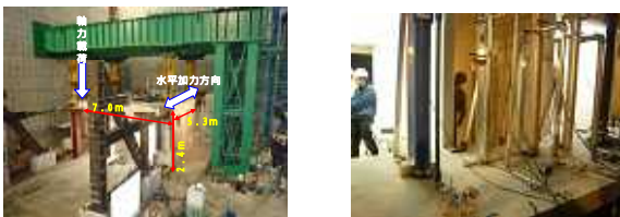
写真 - 6 実大試験体全景 写真 - 7 配管の取り付け状況
