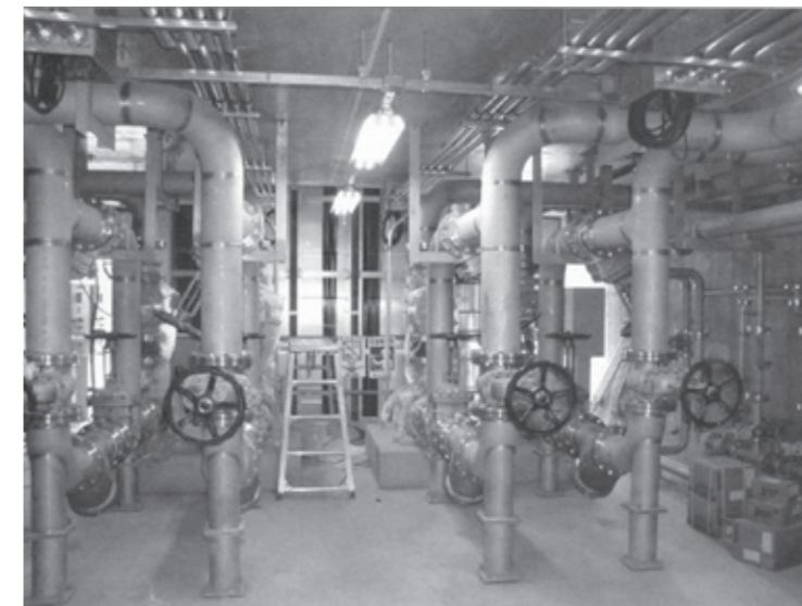
▲浄水場装置配管
