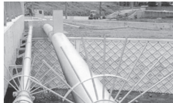
▲橋梁添架形式パイプビーム水管橋
