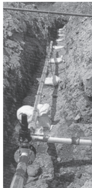
▲自動溶接工法
