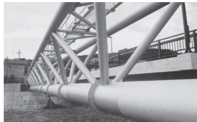
▲トラス補剛形式水管橋
