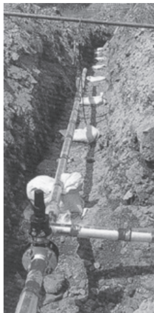
▲自動溶接工法
