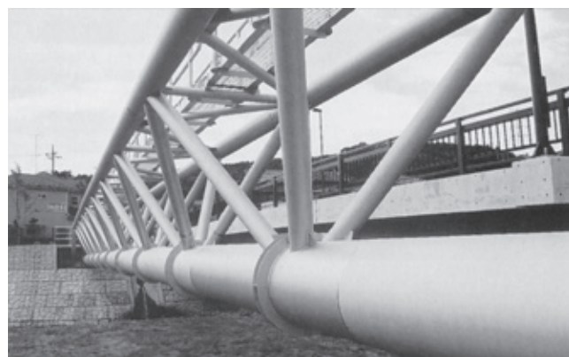
▲トラス補剛形式水管橋
