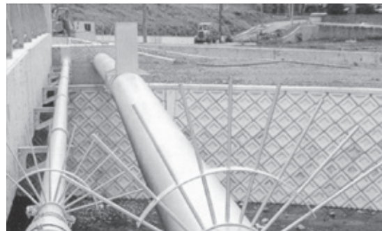
▲橋梁添架形式パイプビーム水管橋
