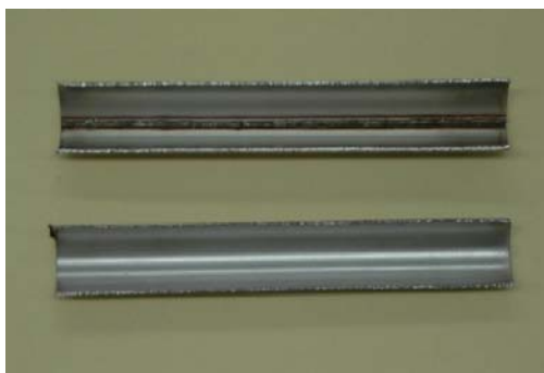
写真.1.施工後 27 年経過後の給湯配管
