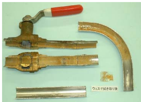
写真.2.施工後 27 年経過後の冷温水配管
