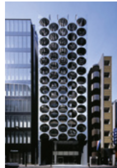
ビル外装パネル
