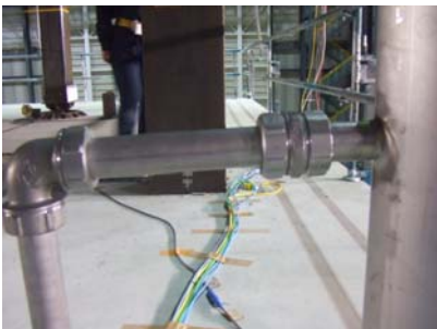
100Su 横引き管の曲がり
