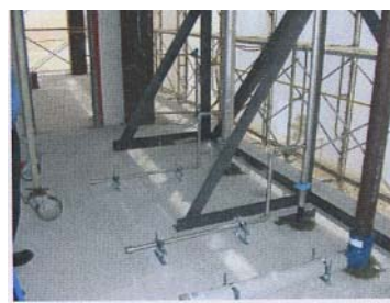
3F 配管状態
