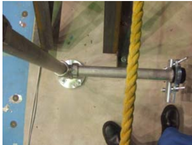
50Su 固定と横引き配管
