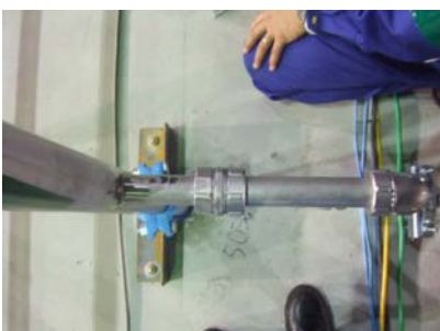
50Su 横引き管の状況
