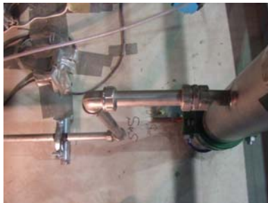
100Su 横引き管の状況
