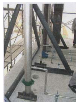
2F 配管状態
