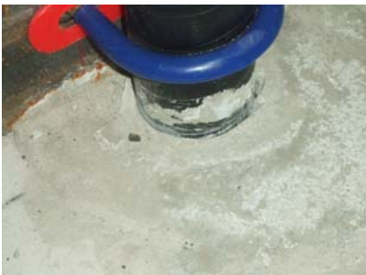
50Su 2階との貫通部
