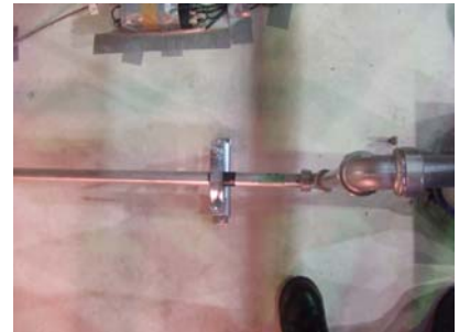
100Su 横引き管の状況
