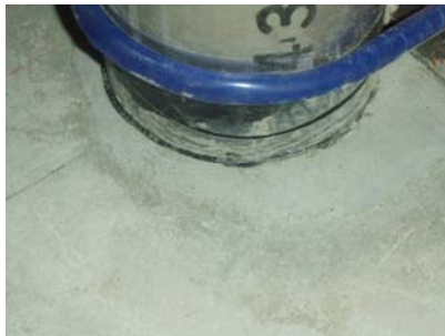
100Su 貫通部の持ち上がり
