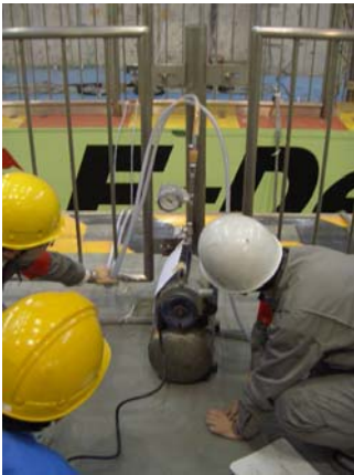
配管加圧状況
