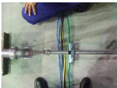
50Su 横引き管の状況
