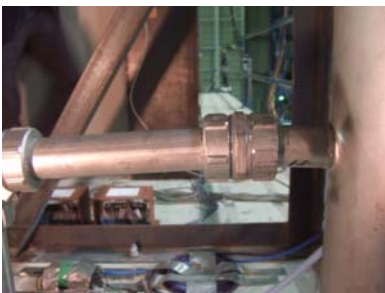
100Su 横引き管の曲がり
