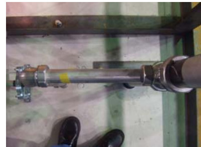
50Su 横引き管の状況
