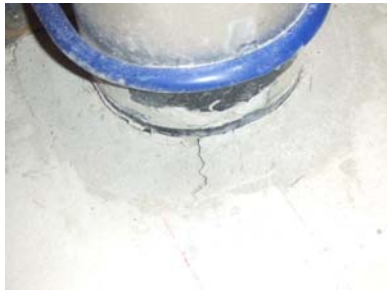
100Su 貫通部の持ち上がり
