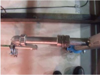
50Su 横引き管の状況
