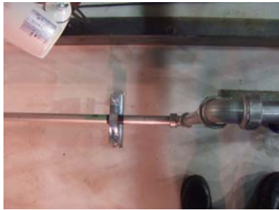
50Su 横引き管の状況
