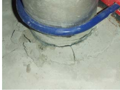
100Su 貫通部の持ち上がり
