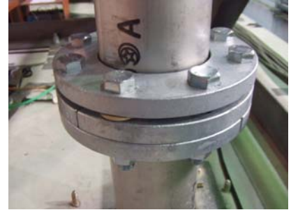
100Su 管端つば出しステンレス鋼管継手
