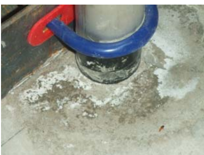
50Su 3階との貫通部
