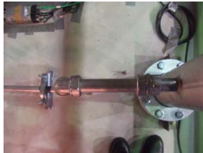
100Su 横引き管の状況
