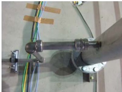
100Su 横引き管の状況
