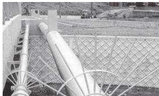
▲橋梁添架形式パイプビーム水管橋
