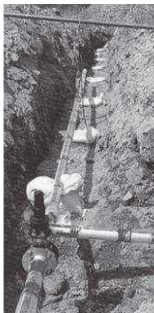
▲自動溶接工法
