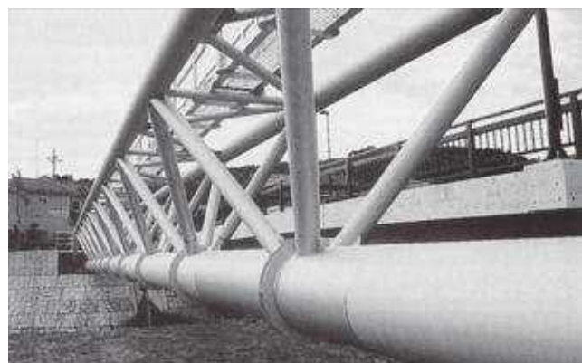
▲トラス補剛形式水管橋
